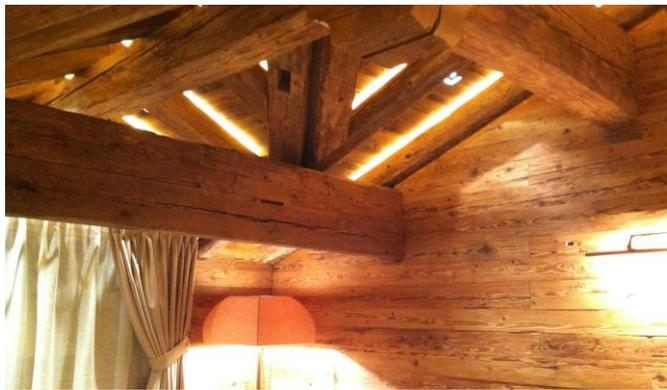
*Etude, conception et réalisation de l'éclairage indirect sur chevron porteur et intégration de spots TBT dans la charpente avec isolation de type sarking*
